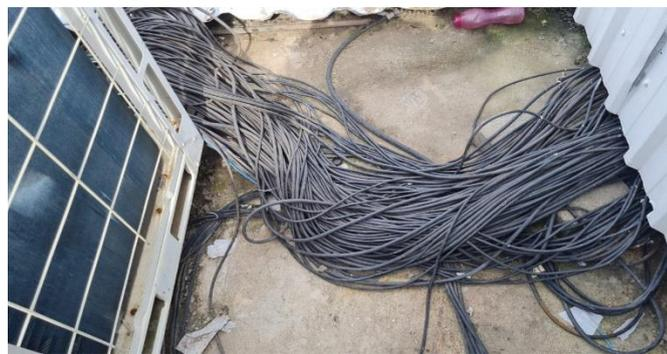
Cabos de energia e comunicação dos Equipamentos de Ar Condicionado se encontram de forma inapropriada e fora das normas padrões estabelecidas. Os Cabos se encontram em estado critico, totalmente expostos ao tempo e ao chão, gerando um alto risco não só aos equipamentos, mas sim as dependências do Prédio da CMM. Serão necessários a criação de caixas e suportes para a devida distribuição e organização de todo o cabeamento de Interligação dos Equipamentos.
