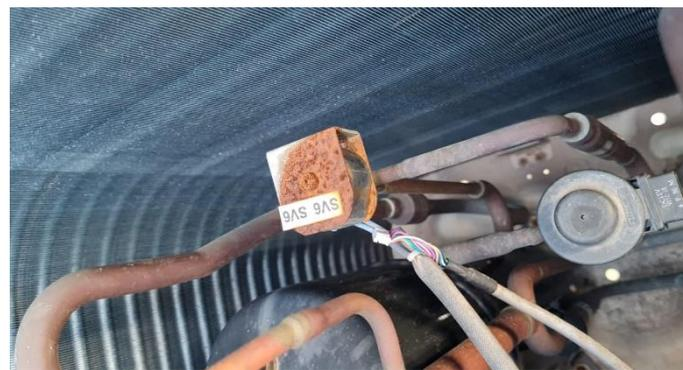
Pressostatos de Alta e Baixa, que são de suma importância para o correto funcionamento e proteção dos equipamentos de Ar Condicionado se encontram desconectadas/anuladas do sistema, os mesmos são responsáveis por efetuar a parada do sistema caso ocorra alguma irregularidade. Estas irregularidades podem ocorrer
