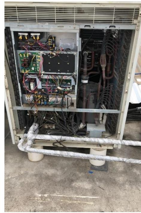
Equipamentos se encontram com falhas múltiplas em seus Módulos, Pressostatos de Alta e Baixa anulados para forçarem os Equipamentos a funcionarem sem as corretas pressões de trabalho, Capacitores do Motor Ventilador em baixo capacitância, resultando numa baixa ventilação dos Motores Ventiladores e conseqüentemente tendo uma deficiência no Sub-Resfriamento, resultando na ineficiência de rendimento dos Equipamentos.
