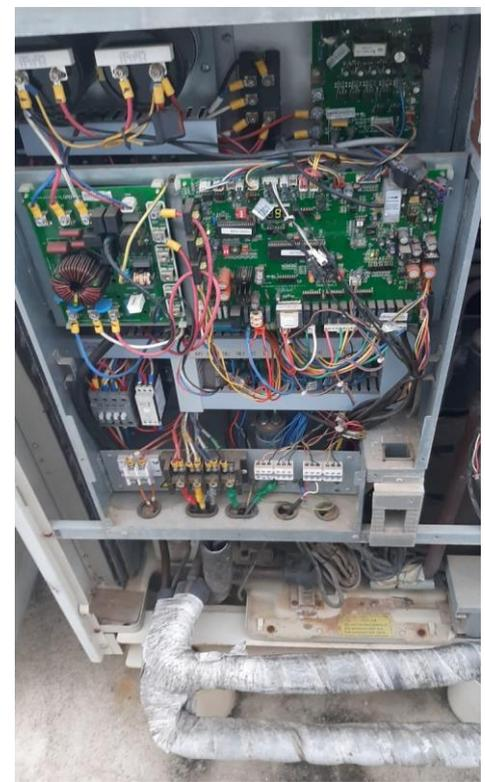
Equipamentos se encontram com falhas múltiplas em seus Módulos, Pressostatos de Alta e Baixa anulados para forçarem os Equipamentos a funcionarem sem as corretas pressões de trabalho, Motor Ventilador queimado, resultando numa baixa ventilação dos Motores Ventiladores e conseqüentemente tendo uma deficiência no Sub-Resfriamento, resultando na ineficiência de rendimento dos Equipamentos.
