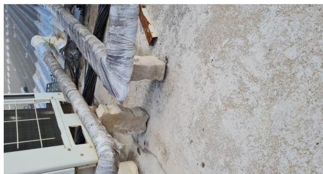
As Tubulações se encontram suspensas através de Latas e Pedras, de forma totalmente incorreta e imprudente. Devido a esta péssima sustentação as Tubulações estão propícias a rachaduras e trincas, resultando assim em vazamentos de Fluido Refrigerant, gerando baixo rendimento de Refrigeração, elevando o consumo de energia, a total falha dos Equipamentos e até mesma a quebra de Compressores.
