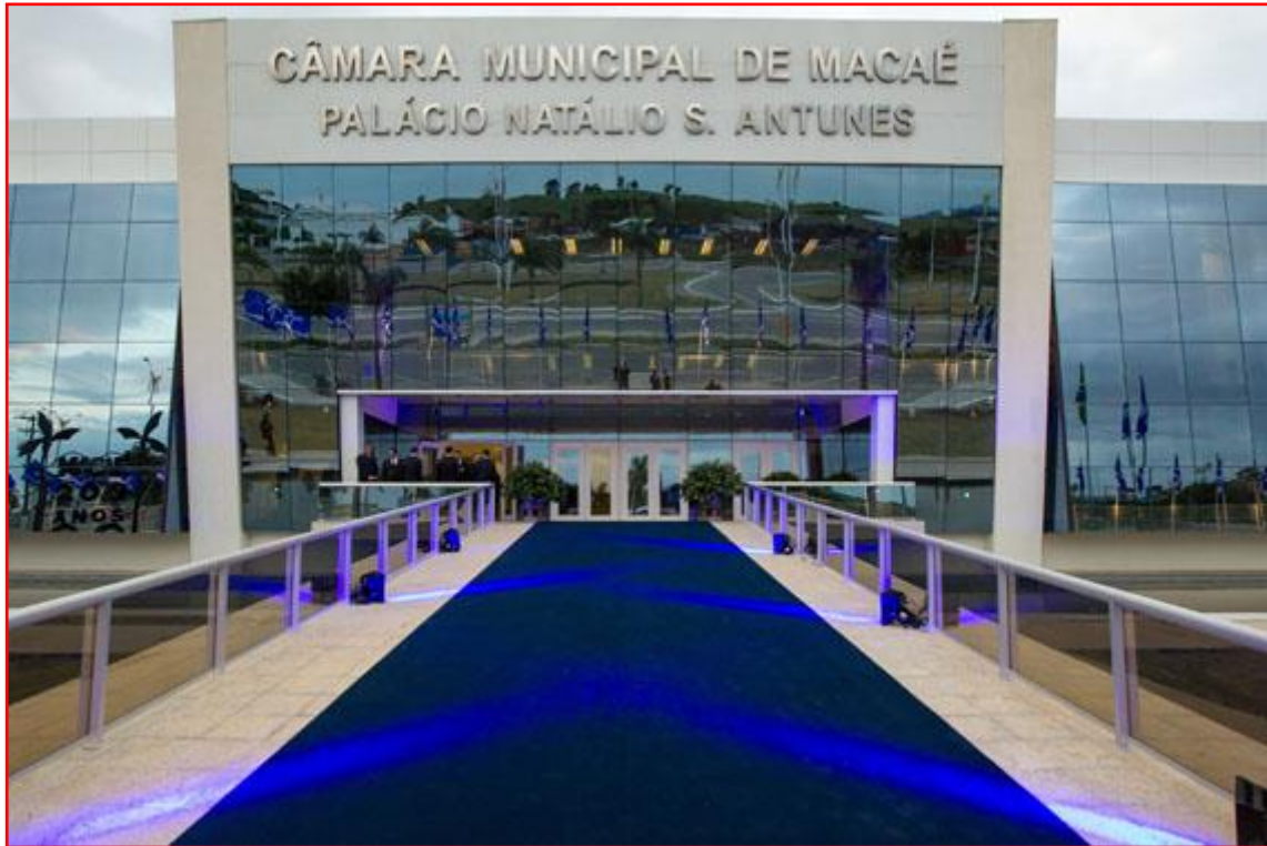
Figura 2 – Fachada Frontal da Edificação.
