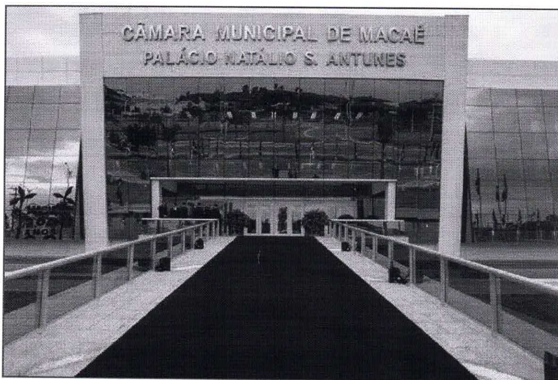
Figura 2 – Fachada Frontal da Edificação.
