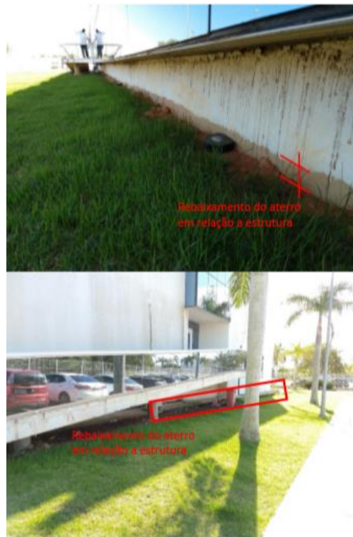
Figura 09 e 10: Deslocamento do aterro em relação ao prédio principal da Câmara Municipal de Macaé-RJ. Ponto 4a, Fonte: Arquivo particular, SENCO, 2019.
